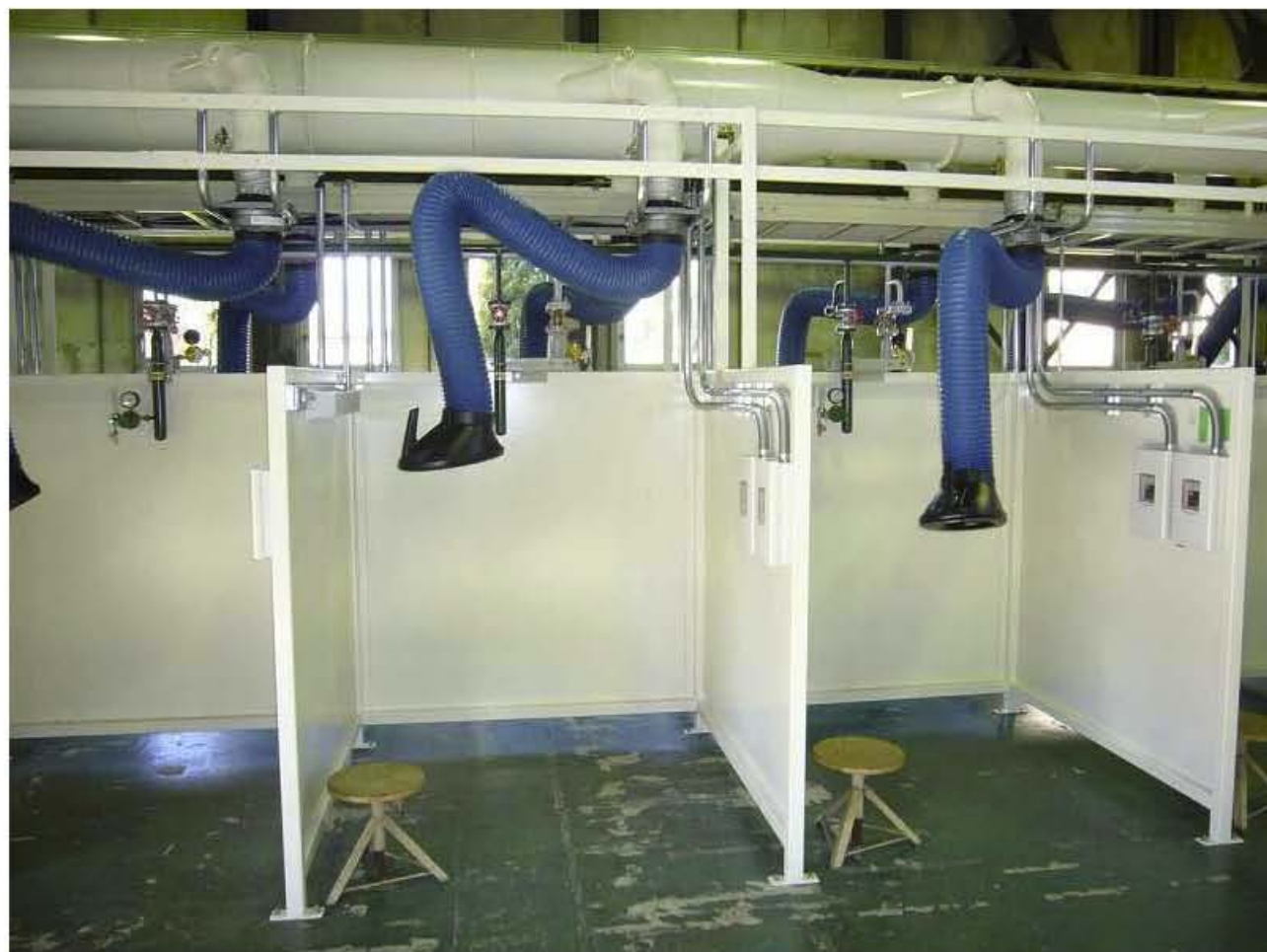
照明、手元配電箱、ガス配管を一体化
